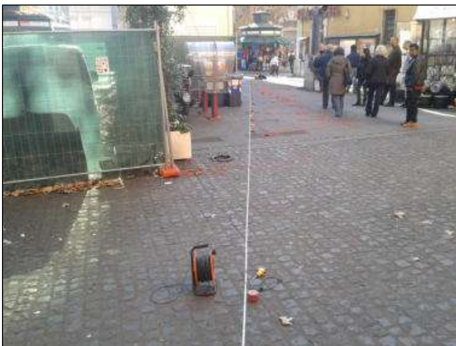
Foto 2. Esecuzione prova geofisica MASW1.
