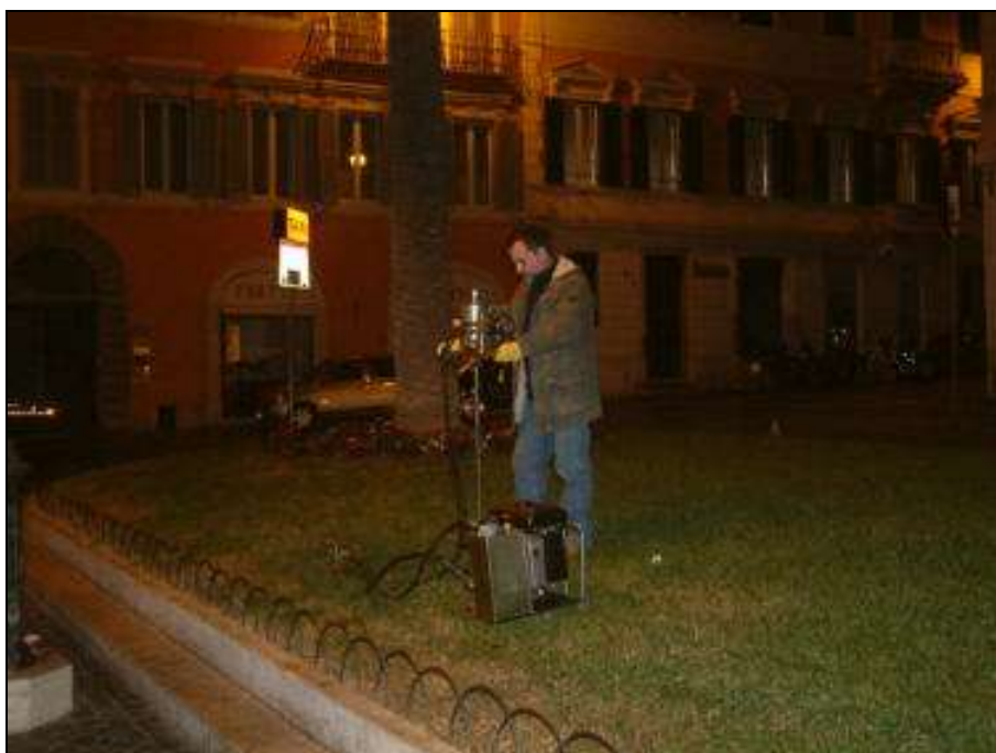
Foto 2. Esecuzione prova penetrometrica dinamica DPM2.
